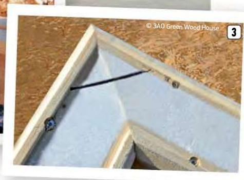
единения являются отсутствие мостиков холода в углах здания за счёт непрерывной прослойки утеплителя и существенная экономия на материалах (10±15%).
