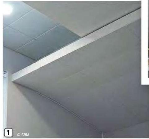
1. Криволинейные подвесные системы из стекловолокна высокой плотности. 2. Для закрепления подвесного потолка на перекрытии лучше использовать виброизолированные подвесы. 3. Звукоизоляционный подвесной потолок
