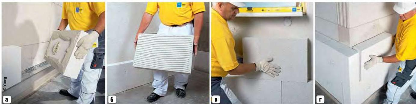
а, б) Алюминиевый профиль устанавливают по уровню и приступают к монтажу первого ряда плит. Плиты клеят на специальный состав. в) Утеплитель Multipor укладывают вразбежку. г) Монтаж изделий на углах здания
