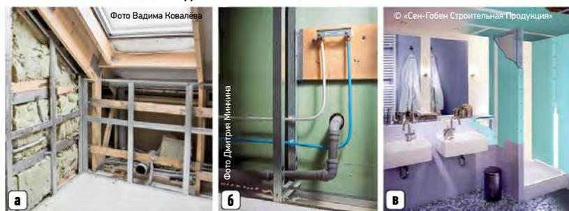
**а) Создание звукоизоляционной перегородки в мансарде. б) Прокладка коммуникаций между направляющими. в) Обшивка каркаса ГКЛВ**
