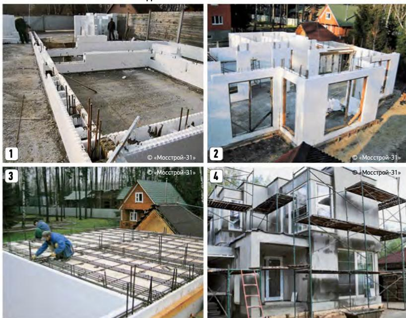
1. Установка первых рядов пенополистирольных блоков и арматурных стержней, которые вместе с бетоном создадут монолитную конструкцию
