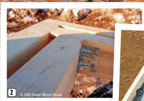
2. Создание обвязки из клеёного бруса. Закладной брус и балки перекрытия располагаются на одном уровне
