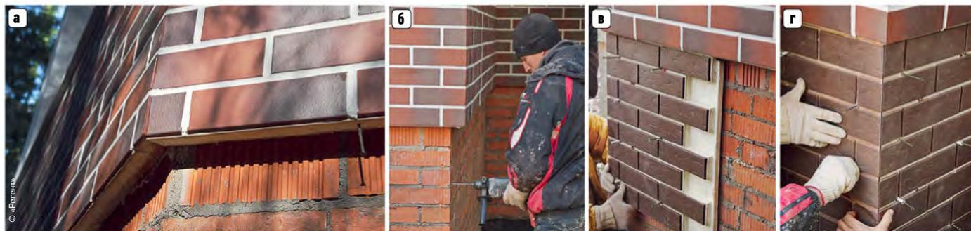
**а)** Монтаж панелей начинают с установки стартового профиля. **б, в)** Крепление осуществляют при помощи саморезов и дюбель-шурупов, для которых в стенах засверливают отверстия. **г)** Точек крепления должно быть не менее шести
