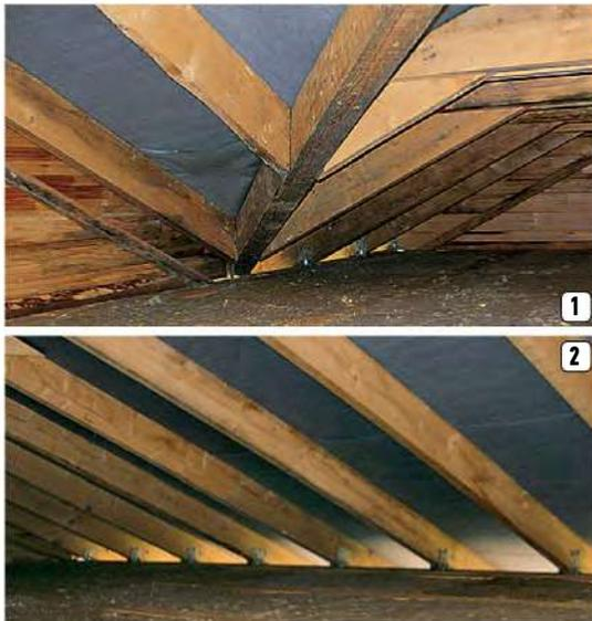
гвоздями длиной 250 мм (их применение разрешает СНиП 2-25-80). Для этой цели в каждом бруске с шагом 1,5 м сделали отверстия диаметром 15 мм и глубиной 30 мм, а затем в них вбили нагели-гвозди, шляпки которых с помощью металлического «добойника» утопили на глубину просверленных отверстий.
