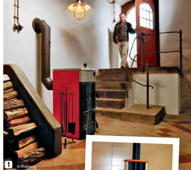
**1, 2.** Если патрубок для подключения расположен у прибора сзади, нужно сразу после него установить тройник или модуль прочистки. При верхнем подключении без этого, как правило, можно обойтись
