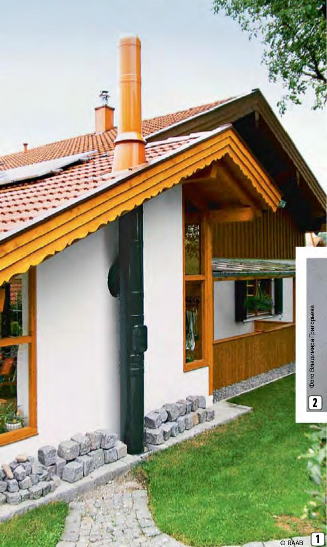
1. При монтаже дымохода сложнее всего собрать узел прохода крыши. Чем дальше от конька расположена труба и чем рельефнее кровельный материал, тем труднее обеспечить гидроизоляцию
