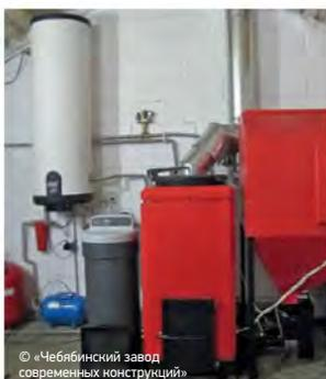
Согласно действующим нормам, котельную необходимо отделать от смежных помещений стенами из негорючих материалов. Ограждающие конструкции из кирпича или бетона, как правило, оштукатуривают и окрашивают. В качестве дополнительной отделки может выступать керамическая плитка или металлические панели.
