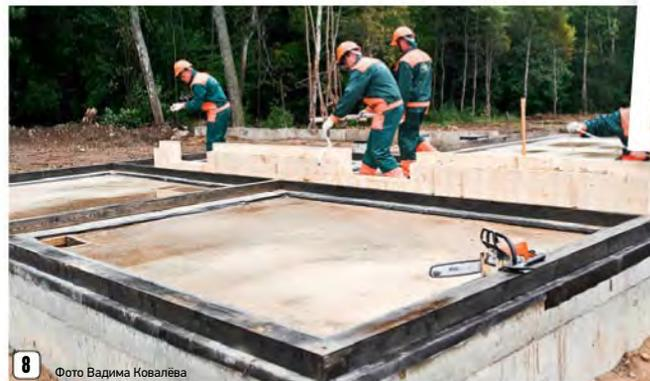
4. Отсечная гидроизоляция поверх ленточного и столбчатого фундаментов
