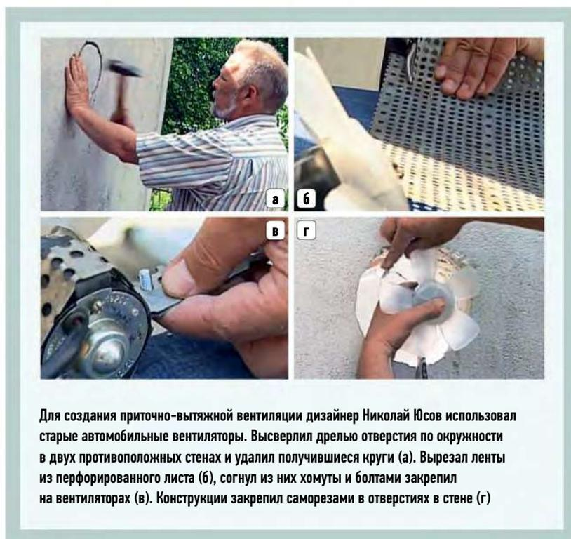
Для создания приточно-вытяжной вентиляции дизайнер Николай Юсов использовал старые автомобильные вентиляторы. Высверлил дрелью отверстия по окружности в двух противоположных стенах и удалил получившиеся круги (а). Вырезал ленты из перфорированного листа (б), согнул из них хомуты и болтами закрепил на вентиляторах (в). Конструкции закрепил саморезами в отверстиях в стене (г)
