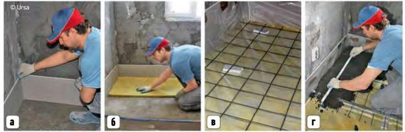
а) По периметру пола укладывают изолирующую прокладку. б) На основание настилают звукопоглощающие плиты. в) Полиэтиленовая плёнка защитит плиты от проникновения влаги из стяжки. г) Поверх плёнки наносят стяжку
