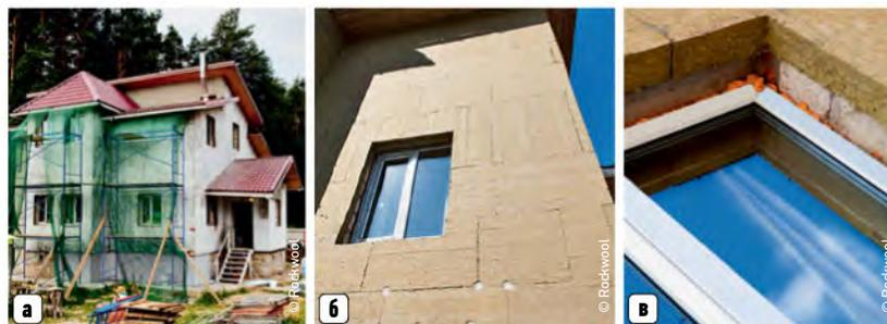
**а) )** Реконструкция данного здания производилась по системе «мокрый фасад». При помощи минераловатного утеплителя толщиной 100 мм, стекловолоконной сетки, клея, обычной штукатурки и деревянных планок каменный дом превратили в фахверк
