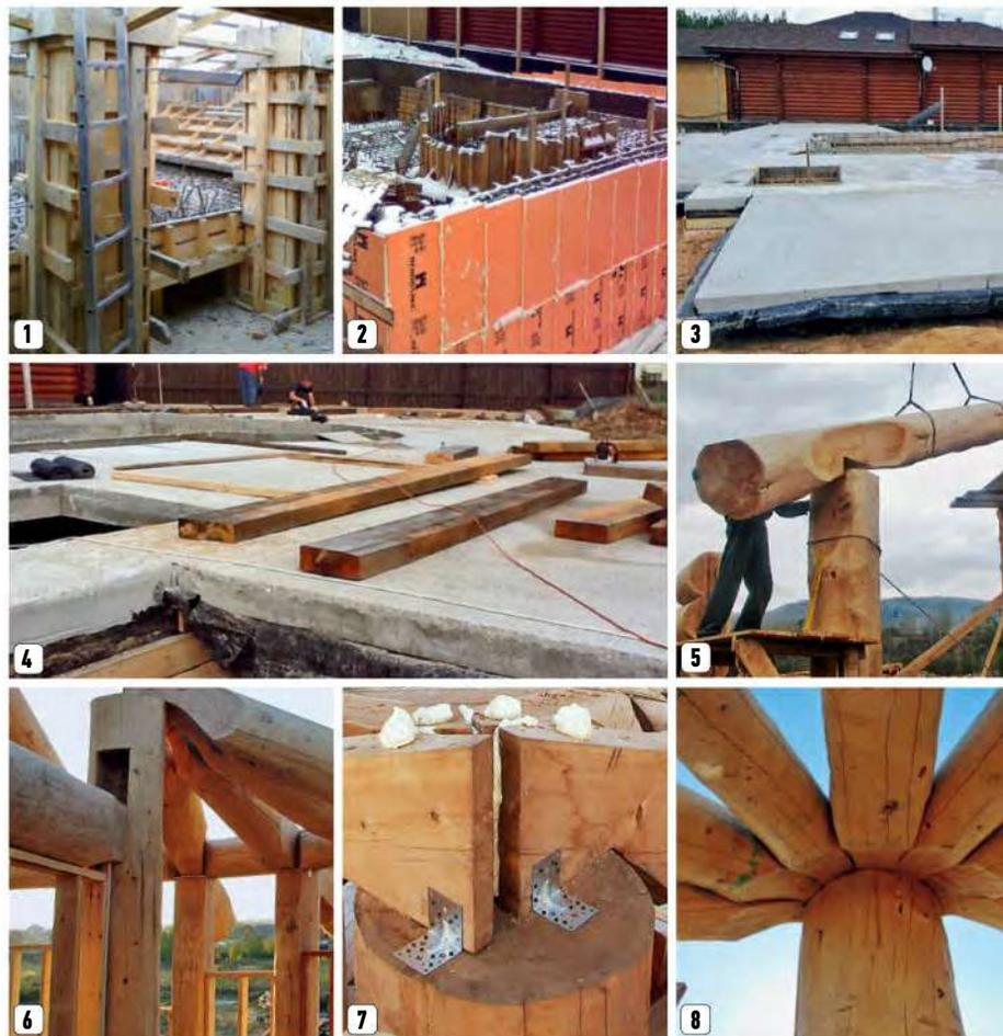
**1–3.** Фундамент дома монолитный. Сначала отпили его нижнюю плиту (лежит на грунте), затем расположенные вокруг бассейна колонны (1) и стены по периметру фундамента (2), а позже – верхнюю плиту (3). Бетонная чаша бассейна отлита отдельно и с фундаментом не связана
