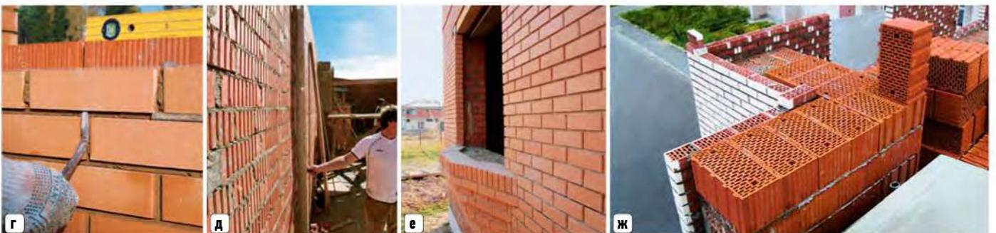
г) Расшивку швов на лицевой кладке выполняют в форме выкружки. д) Неровности стен, выложенных под штукатурку, выявляют правилом. е) Сложные архитектурные элементы выполняют из формового кирпича. ж) Кладка из крупных блоков не требует использования утеплителя
