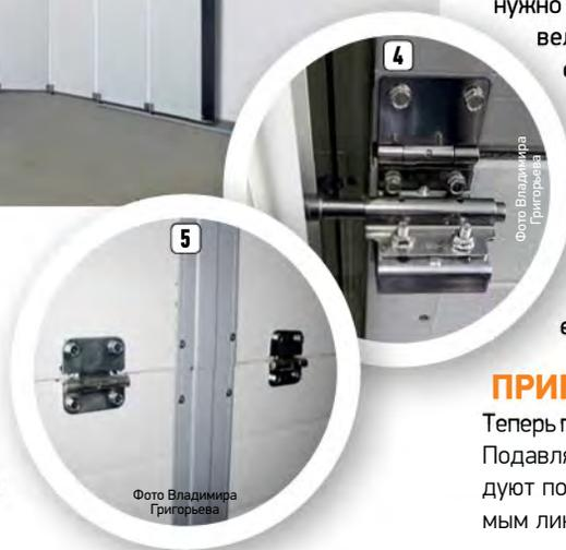
**1, 3.** Воротная система с вертикально ориентированными секциями не слишком популярна из-за того, что требует освободить пространство у стены. **2.** Секционная модель подойдёт и для небольшого бокса, и для просторного гаража загородного дома. **4, 5.** Желательно, чтобы подвижные детали были выполнены из нержавеющей стали
