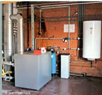
«сэндвич». Модули состоят из двух соосных труб, пространство между которыми заполнено минеральной ватой. В продаже также имеются изделия с внутренней трубой, изготовленной из керамики. Современные дымоходы отличаются высокой безопасно-
