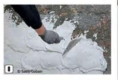
588. В кирпичной кладке просверливают отверстия, инъецируя в них гидроизоляцию. Затем поверхность обрабатывают цементным раствором
