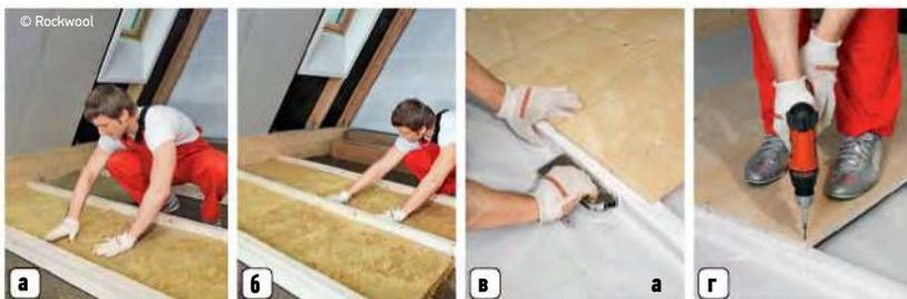
а, б) На основании закрепляют деревянные лаги с необходимым шагом. В пространство между лагами укладывают звукопоглощающий материал. в) Поверх звукопоглощающего слоя настилают пароизоляционную плёнку. г) К лагам фиксируют листы фанеры ± основание для напольного покрытия
