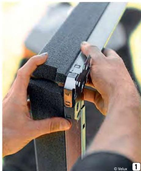
**1. Согласно технологии Velux, крепежные уголки на оконной раме и контуре утепления совмещаются, что позволяет закреплять одновременно оба элемента на обрешётке**
