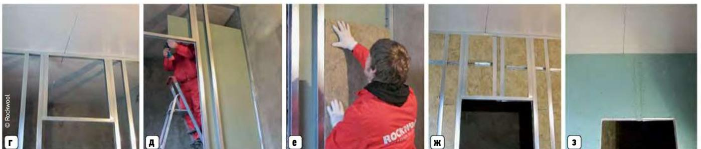
г) Направляющие и стойки соединяют саморезами. д) С одной стороны перегородки крепят ГКЛ. е, ж) Звукоизоляционный материал устанавливают враспор между направляющими. з) Фиксируют ГКЛ с другой стороны перегородки
