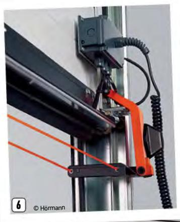
**6. Устройство с фотоэлементами, прикреплённое к нижней секции ворот, остановит электродвигатель, как только на пути луча появится препятствие. Это альтернатива чувствительной кромке, однако последняя на сегодня считается более надёжной. 7. Скорость открывания и закрывания ворот ограничена соображениями безопасности. При этом каждый манёвр включает плавный старт и замедление. Обычно полный цикл занимает не более 1 мин.**
