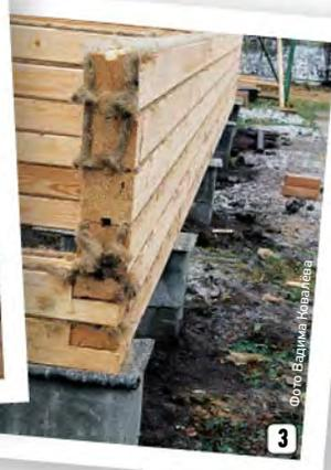
сторон для надёжного соединения с двумя слоями гидроизоляции ± фундамента и конструкции пола первого этажа. Из-за недостаточной прочности и эластичности материала выступающие части полос зачастую обрывают строители при проведении работ. Заменить повреждённую изоляцию, над которой уже возвышается стена, невозможно, а значит, возникает угроза проникновения влаги в этом месте.
