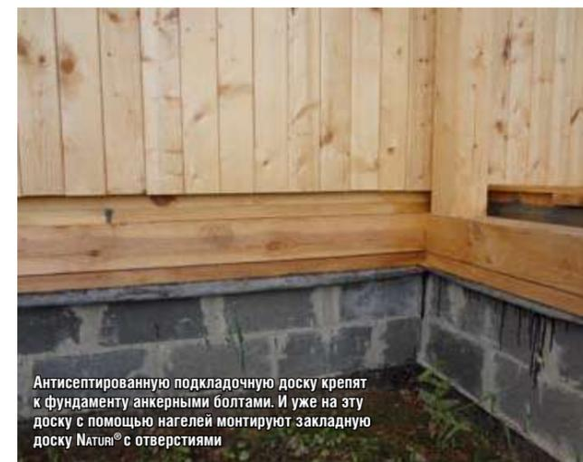
Антисептированную подкладочную доску крепят к фундаменту анкерными болтами. И уже на эту доску с помощью нагелей монтируют закладную доску Naturi® с отверстиями
