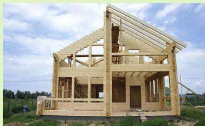
6. Из того же типа материала сделаны балки перекрытий и стропильной системы
