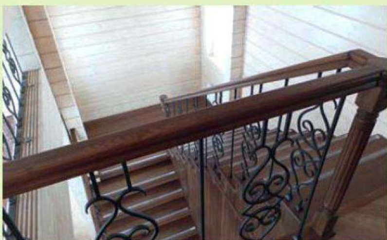
10. Установили межэтажную лестницу и выполнили чистовую отделку помещений
