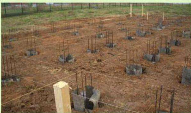
1. В отверстия под сваи диаметром 300 мм, глубиной 1800 мм установили арматуру диаметром 12 мм
