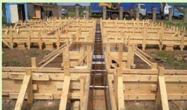
2. Опалубку выполнили из влагостойкой фанеры; каркас ростверка — из арматуры диаметром 12 мм
