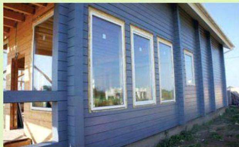
9. Установили оконные блоки и покрыли фасады защитно-декоративными составами
