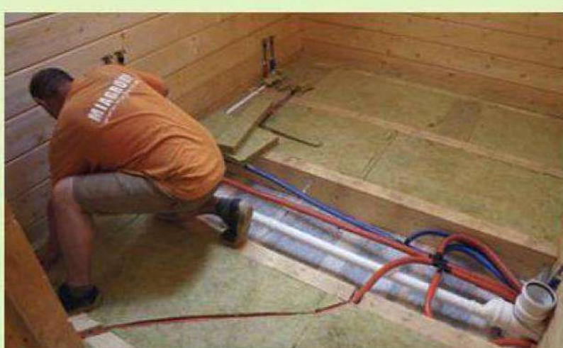
8. Приступили к монтажу инженерных систем и теплоизоляции дома минеральной ватой
