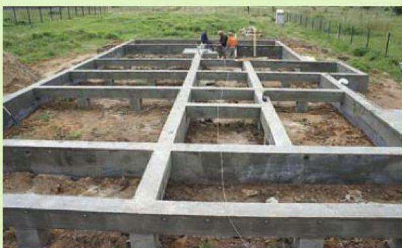
4. В результате получили монолитный свайный ростверк высотой 600 мм и шириной 300 мм
