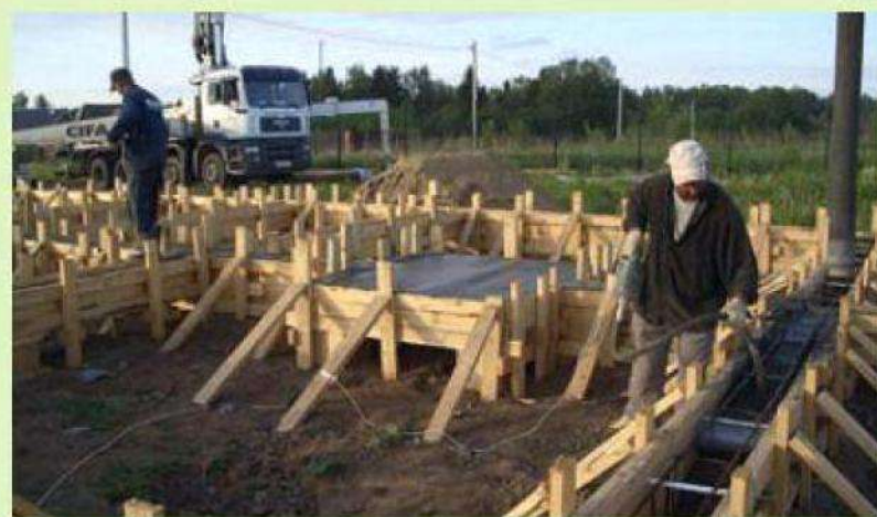
3. Бетонирование фундамента производили с обязательным вибрированием смеси
