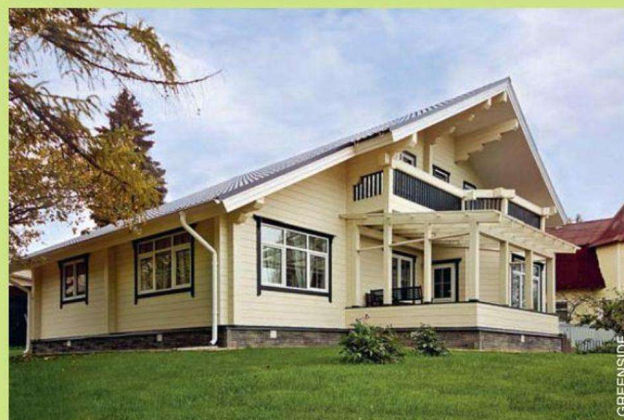
Брусковой дом, занимающий сравнительно небольшую площадь участка, может быть очень просторным внутри
