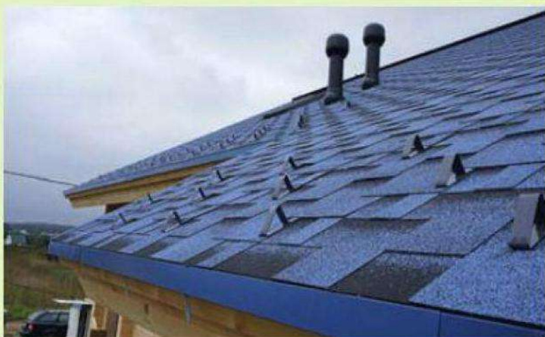
7. Кровлю покрыли гибкой битумной черепицей, предусмотрели систему снегозадержания
