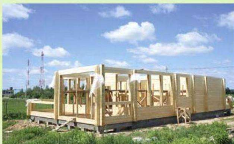
5. Для возведения стен дома был использован клееный профилированный брус
