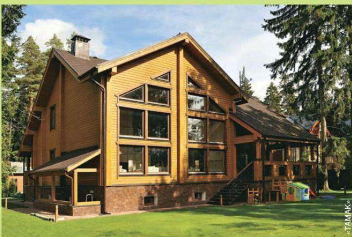
Отделка цоколя искусственным камнем «под гранит» и темные наличники придают светлому дому визуальную четкость
